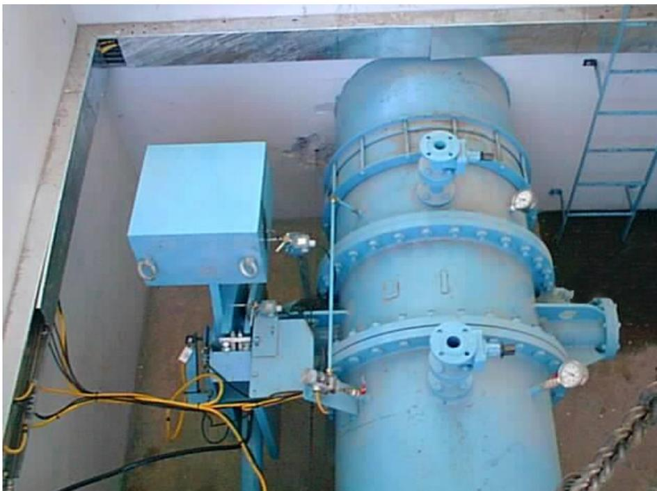
*Figura 3: valvola a farfalla DN1200 installata presso l'ingresso in centrale*
