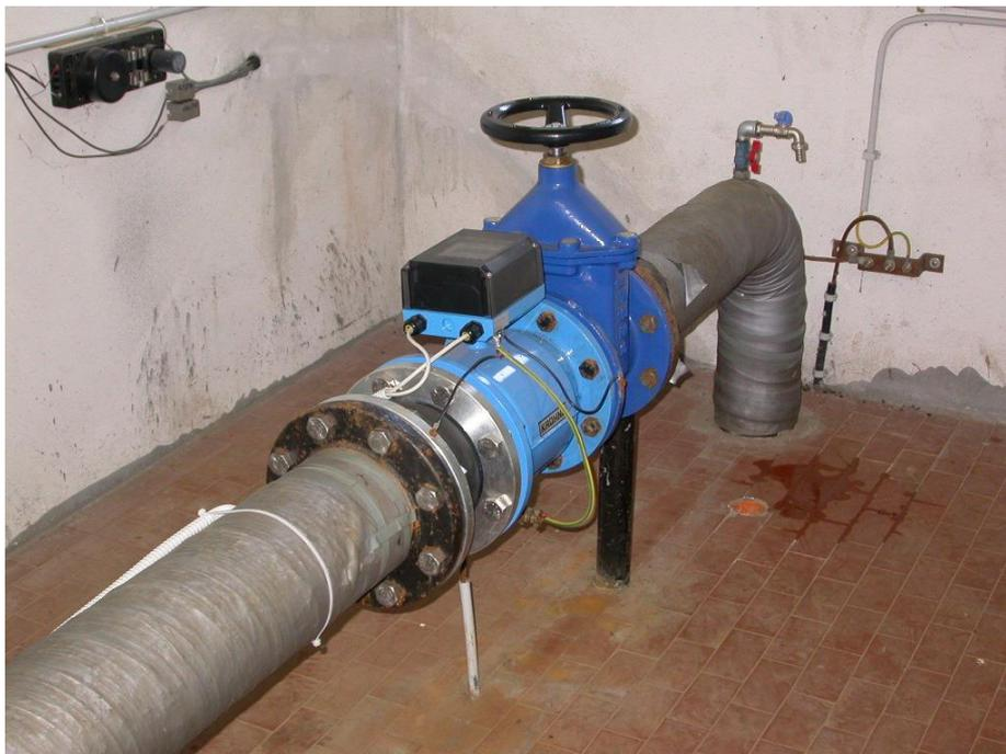
Figura 7: Misuratore di portata elettromagnetico (in azzurro) installato su tubazione.
