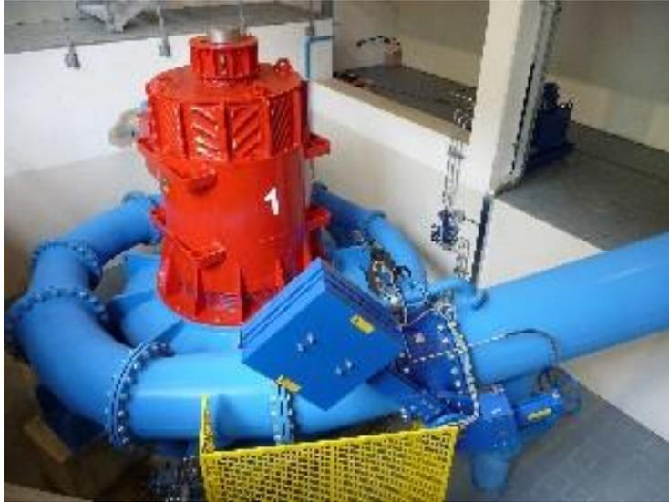
Figura 8 : centrale attrezzata con una turbina Pelton a 5 getti ed asse verticale.
