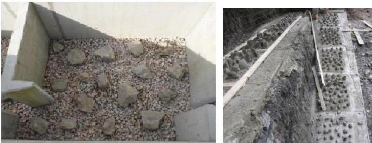
Figura 2: Esempi di realizzazione di un substrato roccioso su scale di rimonta (Comoglio, et al., 2013).
