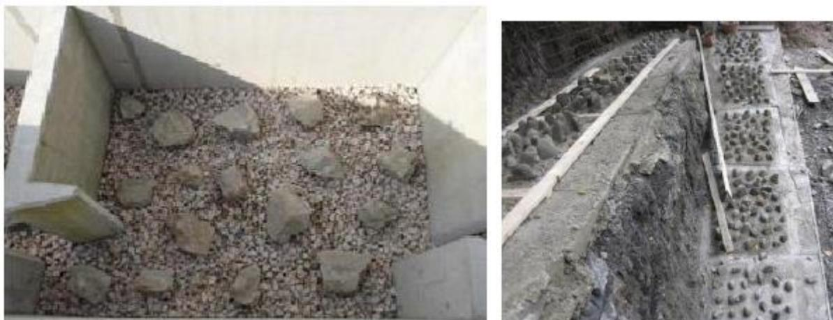
Figura 7: Esempi di realizzazione di un substrato roccioso su scale di rimonta (Comoglio, et al., 2013).
